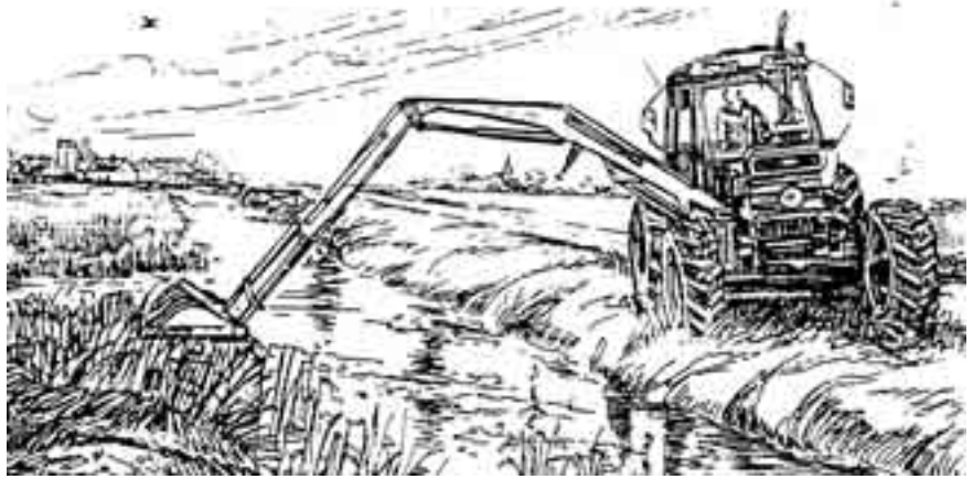
Fig. 4.0 Het opschoonen van een watergang zorgt voor een verbeterde waterafvoer.
